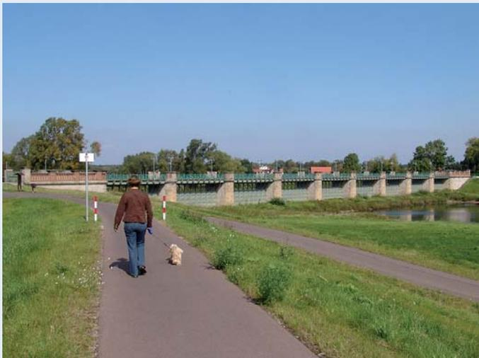
Einen Zwischenstopp am **Pretziener Wehr (1871 bis 1875)** sollten Sie auf jeden Fall mit einplanen. Mit einer Länge von 162,80 m und 324 Schützentafeln ist es das größte Schützentafelwehr Europas. Als ingenieurtechnische Höchstleistung seiner Zeit erhielt die Konstruktion im Jahr 1889 auf der Weltausstellung in Paris eine Goldmedaille. Noch heute ist es voll funktionsfähig und wird bei einem Elbpegel in Barby von 4,98 m gezogen.
